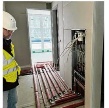
Der Estrich in Haus 1 fehlt noch; man sieht die Leitungen für die Fußbodenheizung.
