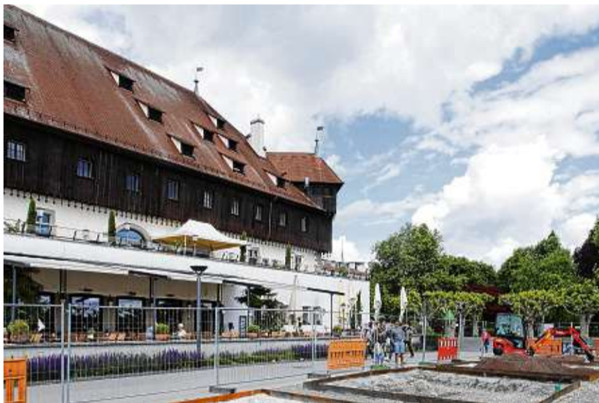
Die Umgestaltung des Konzilvorplatzes hat begonnen. Im ersten Bauabschnitt werden die Staudenbeete zwischen Wiese und Konzilgebäude (Foto) angelegt, später folgt die Einbettung der Brunnen in ein Holzdeck. BILD: AURELIA SCHERRER
