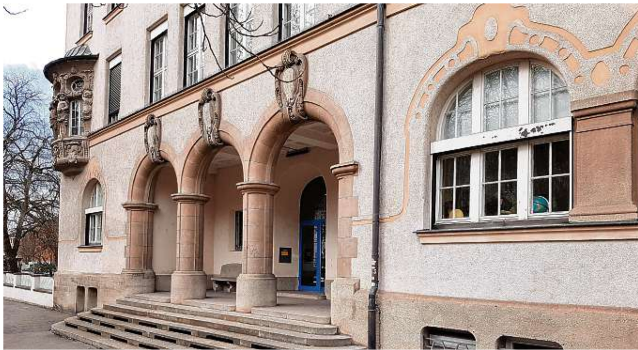
Der Eingang der Theodor-Heuss-Realschule. Kommunalpolitiker wollen sie schließen, um mehr Gemeinschaftsschüler aufnehmen zu kön- nen. Nun stärken Pädagogen anderer Schulen dem Haus den Rücken. BILD: EVA MARIE STEGMANN
